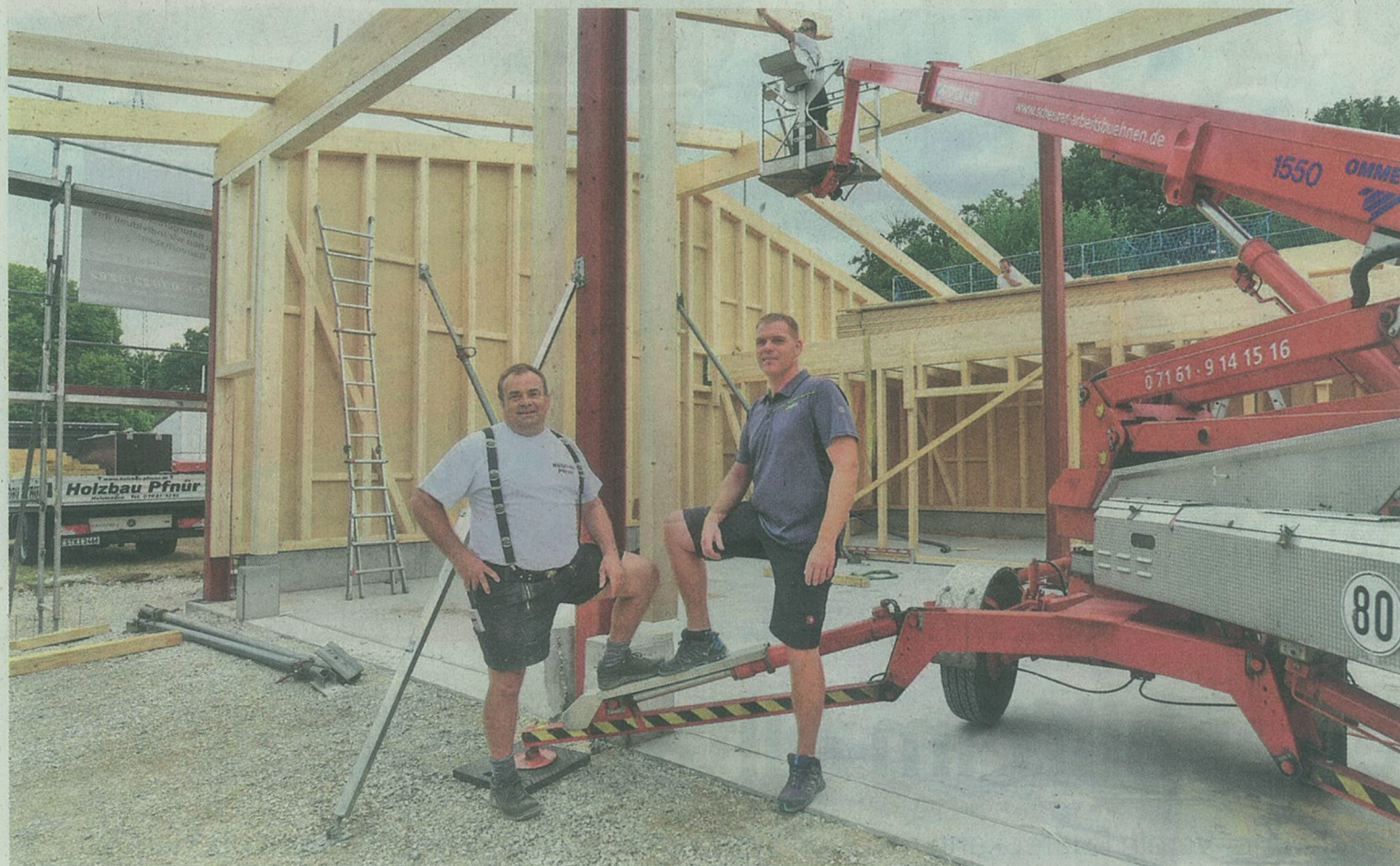
Bauleiter Robert Pfnür (links) zeigt Matthias Jensch den Fortschritt der Arbeiten. Die Halle entsteht komplett in ökologischer Holzbauweise mit Holz aus heimischen Wäldern, betont Pfnür.
